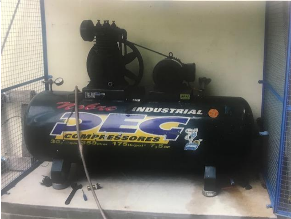
V.P. nº 8 – Fundo do prédio 10
