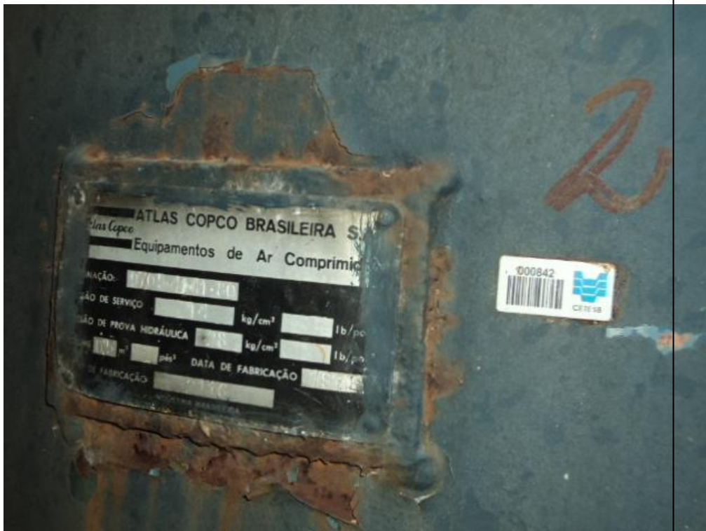
V.P. nº 2 – Fundos do Prédio 3 - (Área descoberta, vizinho ao V.P. nº1).
