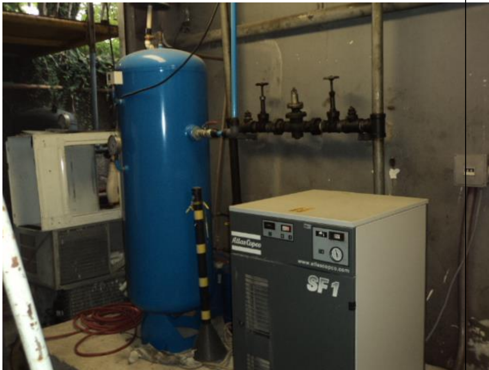
V.P. nº 3 – Fundos do Prédio 3 - (Área coberta, próximo a bomba de vácuo)
