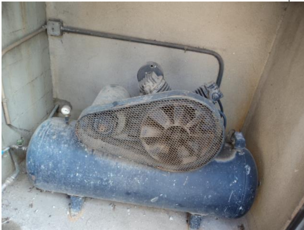
V.P. nº 7 – Ao Lado do prédio 7, possui abrigo próprio.
