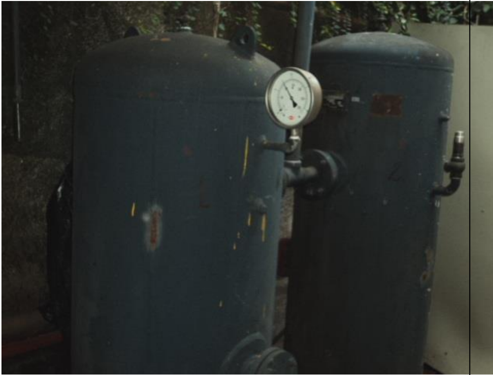
V.P. nº 1 – Fundos do Prédio 3 - (Área descoberta)
