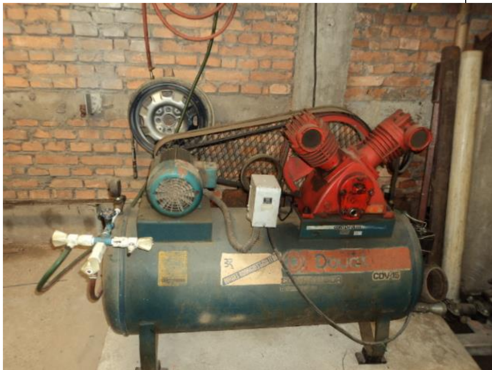
V.P. nº 5 – Sub Solo do prédio 5.
